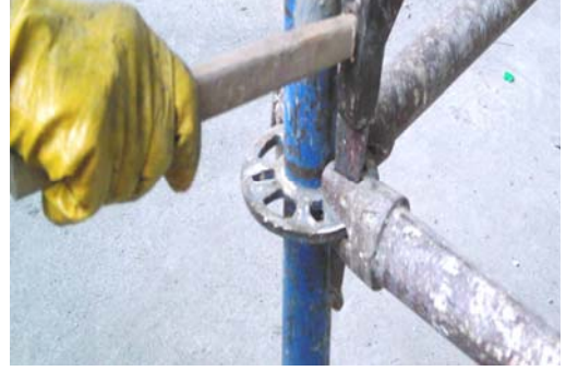
Resim 86: Kısa Kenar yatay bağlantı elemanının monte edilmesi
