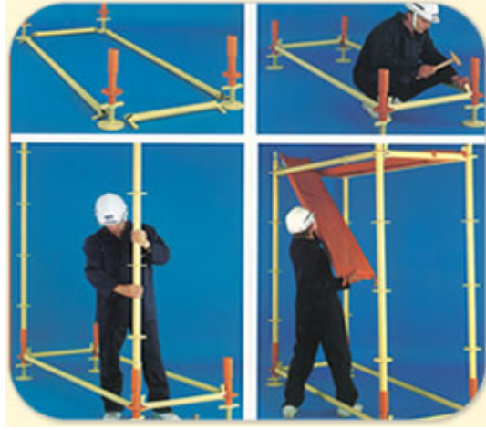
Resim 49: Metal iskelenin kurulması örneği
