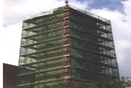
Resim 95.2: İskele dışının kaplanması
