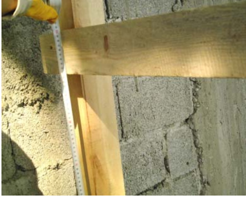
Resim 40: Boyunduruk mesafelerinin ölçülmesi
