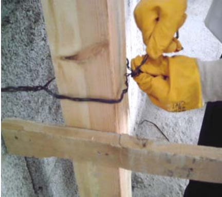
Resim 30: Telin dikmeye bağlanması
