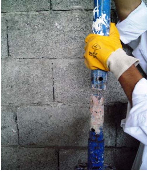
Resim 81: Dikmelerin ek yapılarak yükseltilmesi
