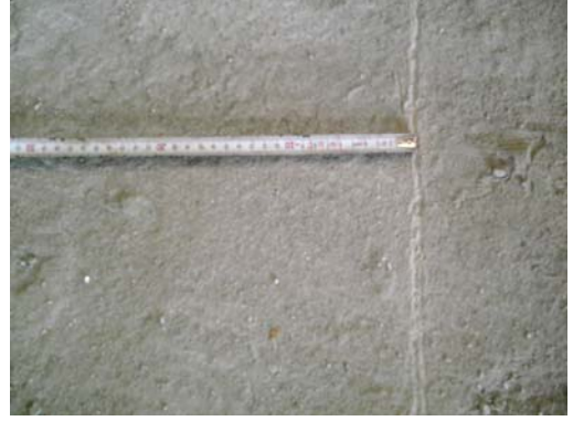
Resim 54.2: İskele yapılacak yerin ölçülmesi
