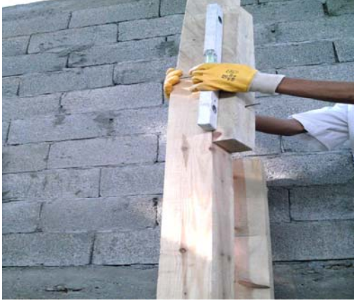
Resim 32: Dikmelere ek yapmak için düşeyliğin su terazisi ile sağlanması
