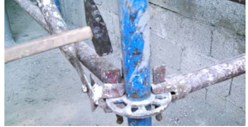
Resim 88: Çapraz bağlantıların monte edilmesi
