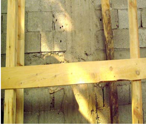
Resim 44: Alt korkuluğun bitmiş hali
