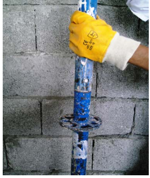
Resim 82: Dikmelerin eklenmiş hali
