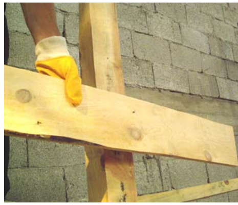
Resim 105: Alt korkuluğun sökülmesi
