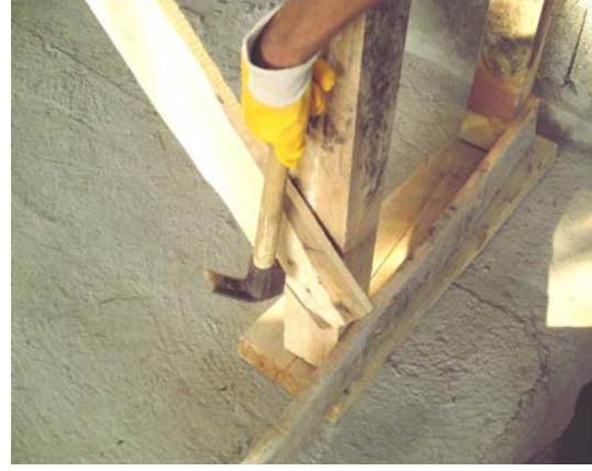
Resim 22: Çaprazların iskele içinden çakılması Resim 23: Çaprazların iskele dışından çakılması
