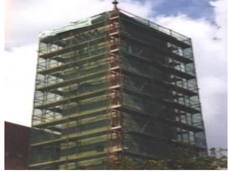
Resim 132.2: İşkele dış kaplamasının sökülmesi
