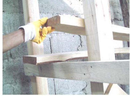
Resim 119: Alt platform kalaslarının sökülmüş hali
