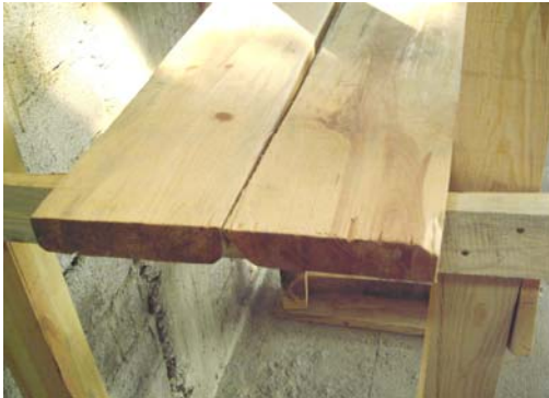
Resim 26: Kalasların yerleştirilmesi
