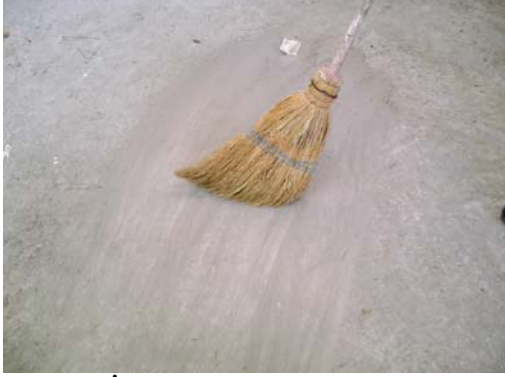
Resim 8: İskele yapılacak yerin temizlenmesi
