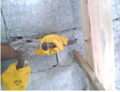
Resim 28: Çelik tel için duvara delik açılması
