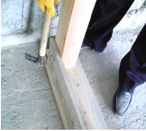
Resim 18: Kuşanın dikmelere çakılması
