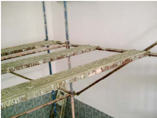
Resim 73: İskele platformlarının oluşmuş hali
