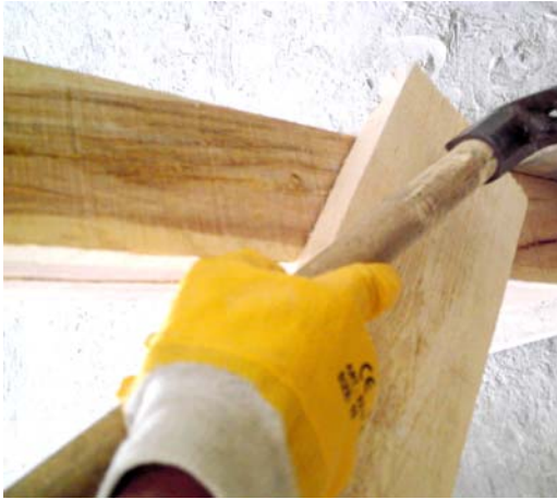
Resim 38: Çapraz kuşakların boyundurukla çakılması
