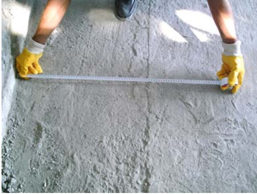
Resim 10: İskele yapılacak yerin genişliğinin ölçülmesi
