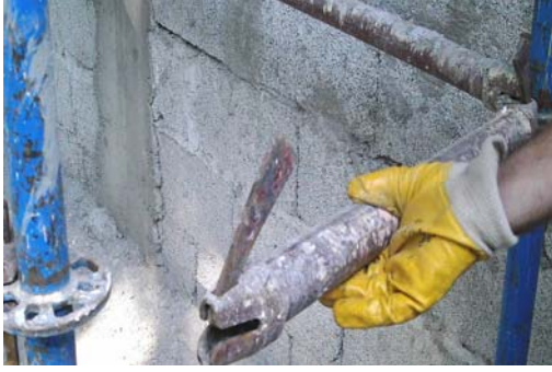
Resim 85: Kısa kenar bağlantı elemanının bağlanması
