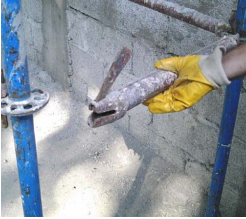
Resim 65: Kısa kenar yatay bağlantı elemanının yerine yerleştirilmesi
