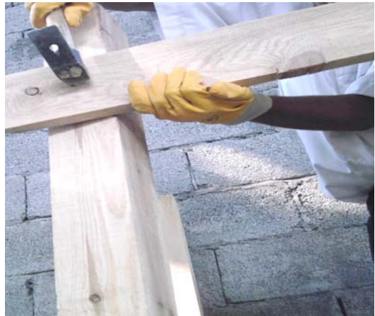
Resim 43: Alt korkuluğun çakılması
