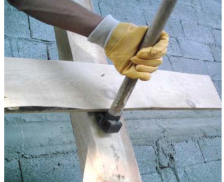
Resim 103: Üst korkuluk çivilerinin sökülmesi
