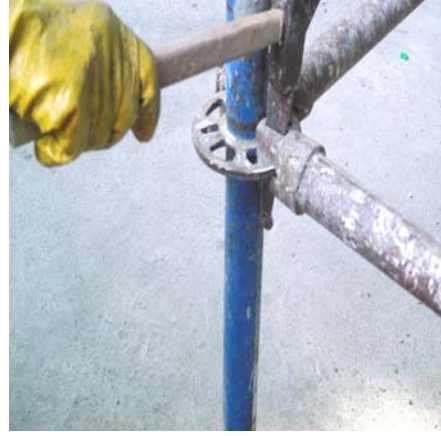
Resim 66: Kısa kenar bağlantı elemanının dikmelere monte edilmesi
