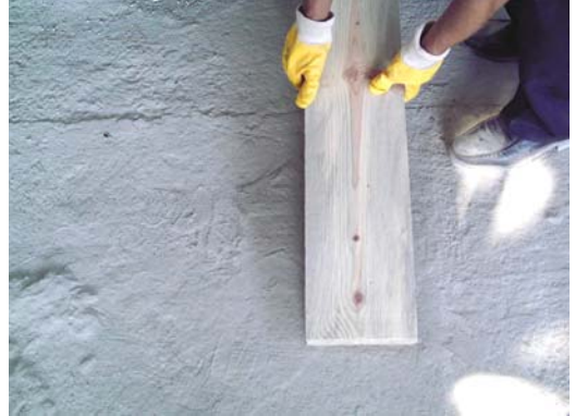
Resim 13: Yastıkların yerleştirilmesi
