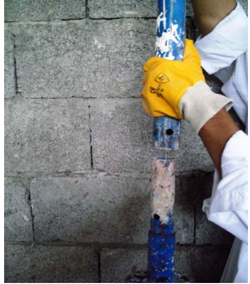
Resim 146: Dikmelerin sökülmesi
