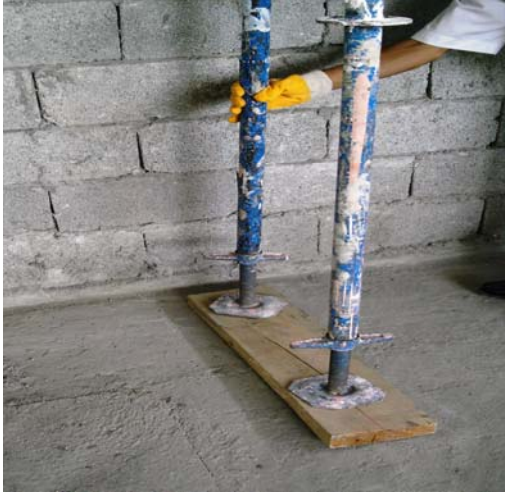
Resim 61: Dikme aralıklarının ayarlanması
