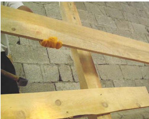
Resim 104: Üst korkuluğun sökülmesi
