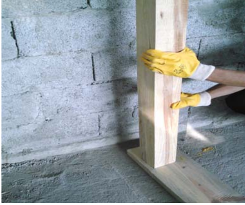
Resim 14: Dikmenin yerleştirilmesi
