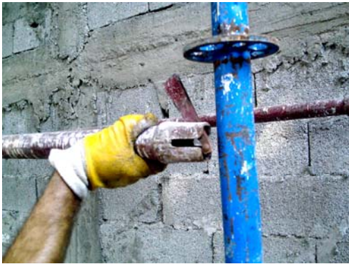
Resim 83: Yükseltilmiş bölümün yatay bağlantı elemanlarının bağlanması
