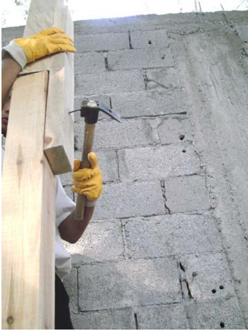
Resim 34: Şaplamanın alt dikmeye çakılması
