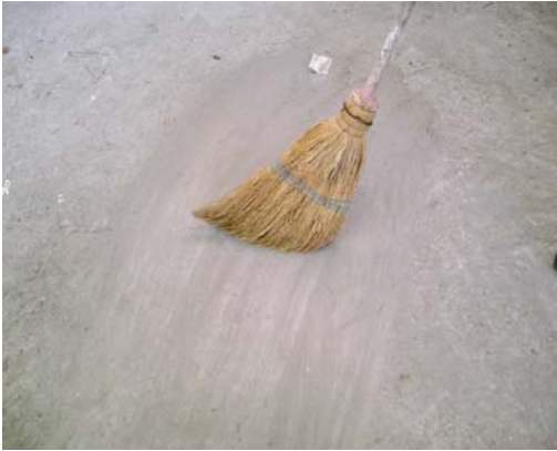
Resim 130: İskele gereçlerinin yerinin temizlenmesi
