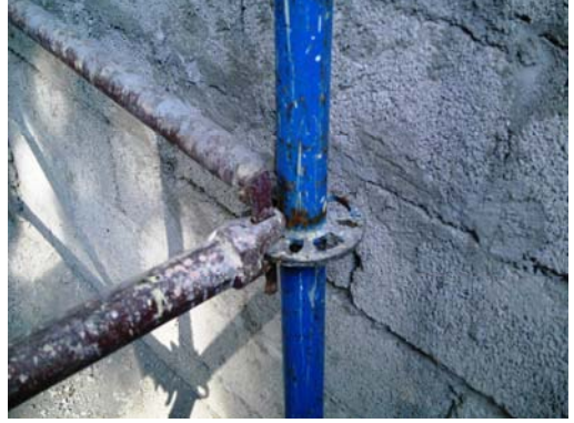
Resim 144: Aparatların sökülmüş hali
