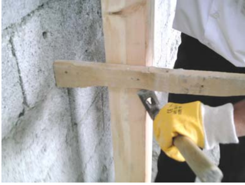
Resim 114: Klapaların sökülmesi
