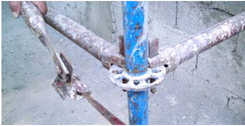
Resim 87: Yükseltilmiş bölümün çapraz bağlantılarının yerlerinin belirlenmesi
