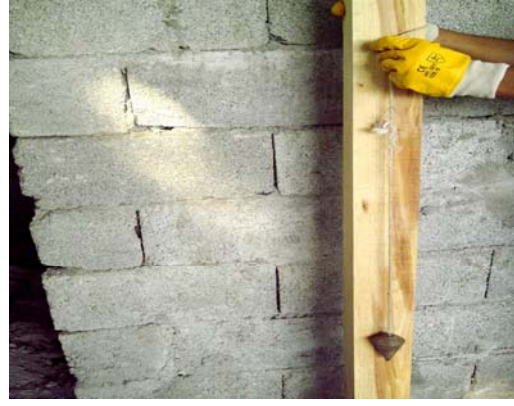
Resim 17: Dikmelerin düşeyliğinin çekül ile sağlanması
