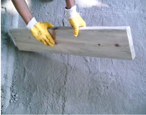
Resim 55: Yastıkların yerleştirilmesi
