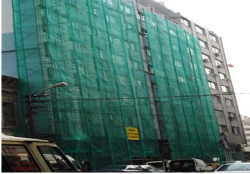
Resim 46.1: İskele dışının kaplanması
