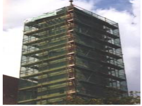
Resim 101.2: İskele dış kaplamasının sökülmesi
