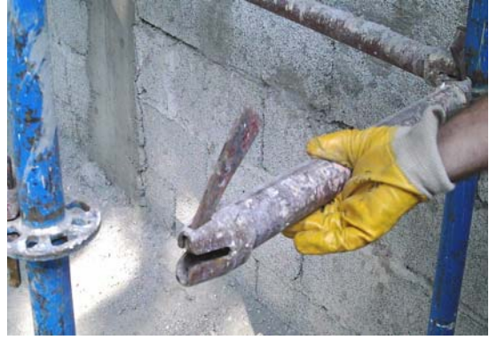
Resim 140: Yatay bağlantıların sökülmüş hali
