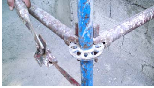
Resim 138: Çaprazların sökülmesi
