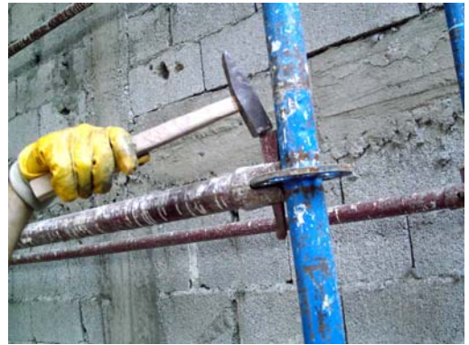
Resim 84: Yatay bağlantıların monte edilmesi
