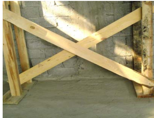
Resim 24: Çaprazların boyunduruklara çakılması Resim 25: Çaprazların çakılmış hali
