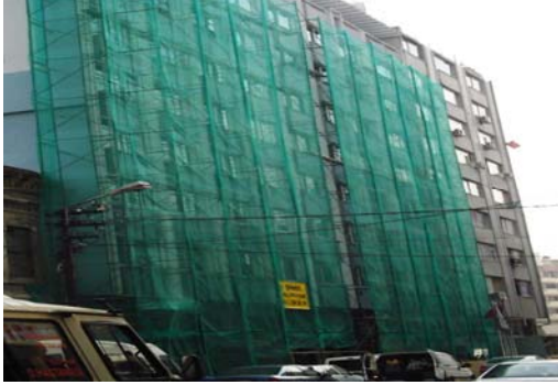
Resim 132.1: İşkele dış kaplamasının sökülmesi
