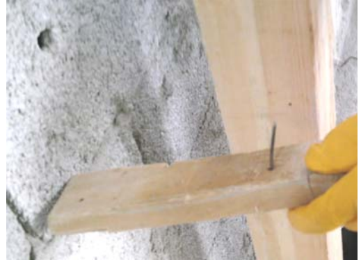
Resim 115: Klapaların sökülmüş hali
