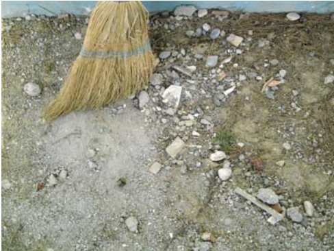
Resim 53.1: İskele yapılacak yerin temizlenmesi
