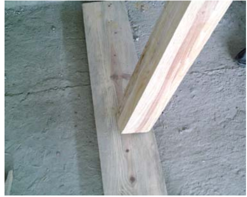
Resim 121: Alt kısımdaki kuşakların sökülmüş hali
