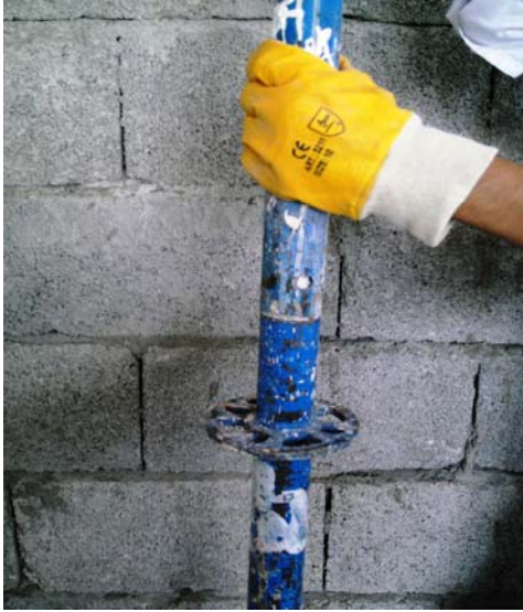
Resim 145: Dikmelerin sökülmesi
