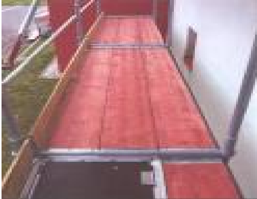
Resim 93: İskele platformunun yapılmış hali
