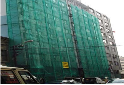
Resim 101.1: İskele dış kaplamasının sökülmesi
