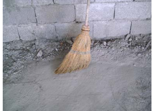
Resim 53.2: İskele yapılacak yerin temizlenmesi
