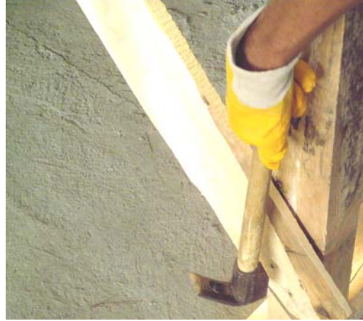
Resim 37: Üst dikmenin dıştan çapraz kuşak bağlanması
