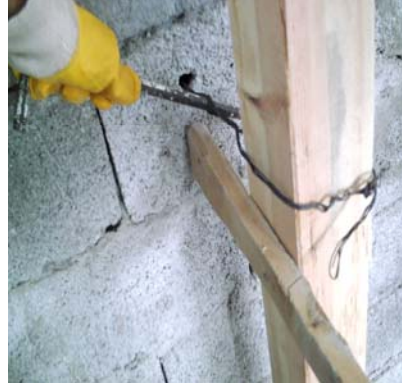
Resim 31: Çelik telin gergin hale getirilmesi
