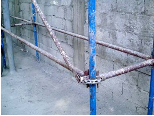
Resim 69: Çapraz Bağlantı elemanlarının montajı
