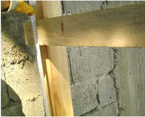
Resim 20: Boyunduruk yüksekliğinin ölçülmesi
