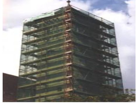
Resim 46.2: İskele dışının kaplanması
