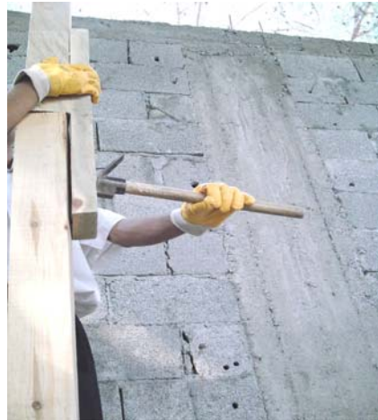
Resim 117: Eklenmiş dikmelerin sökülmesi
