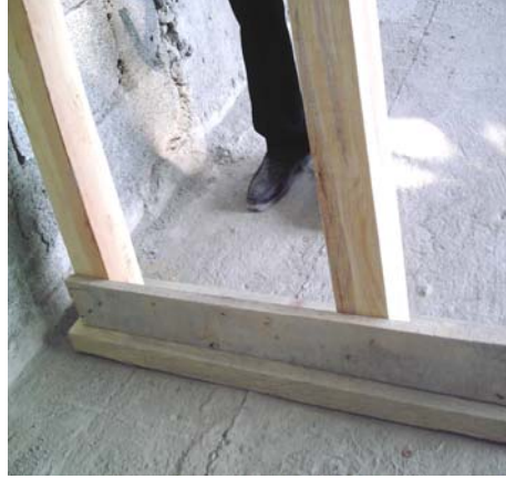
Resim 19: Dikmeleri alttan kuşakla bağlanması
