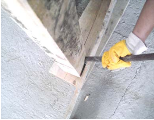
Resim 120: Alt kısımdaki kuşakların sökülmesi
