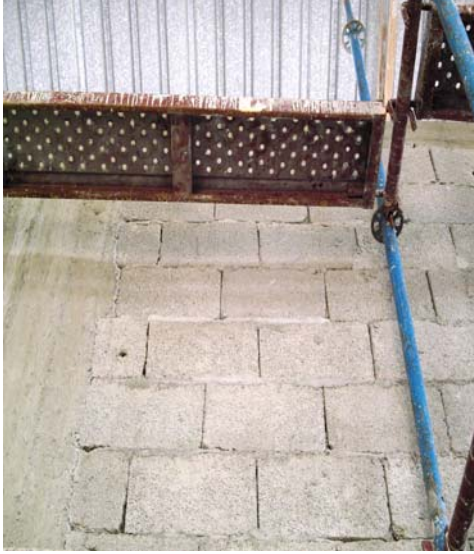
Resim 147: Alt Platform kalaslarının sökülmesi
