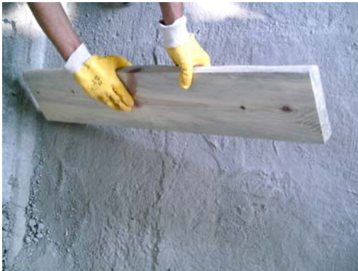
Resim 12: Yastıkların yerlerinin belirlenmesi
