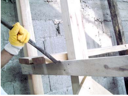
Resim 118: Alt platform kalaslarının sökülmesi
