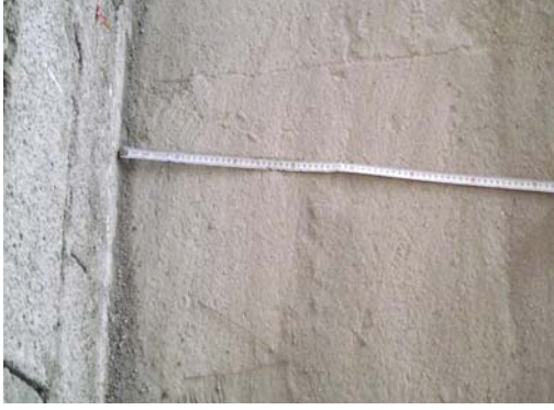
Resim 54.1: İskele yapılacak yerin ölçülmesi
