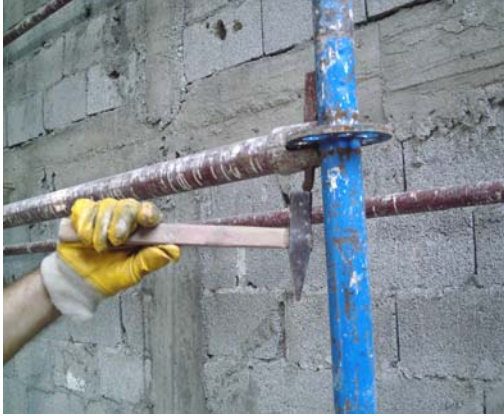
Resim 133: Korkuluğun sökülmesi
