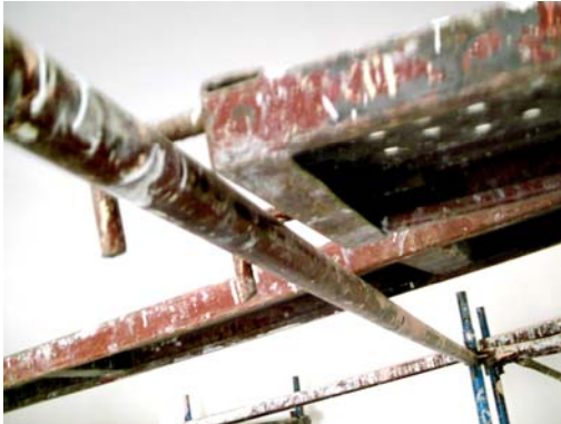
Resim 71: Metal kalasların yerlerinin belirlenmesi hali
