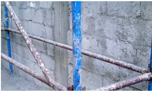
Resim 89: Çarpa bağlantıların bağlanmış hali
