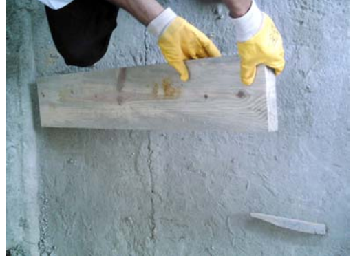
Resim 152: Yastıkların sökülmüş hali
