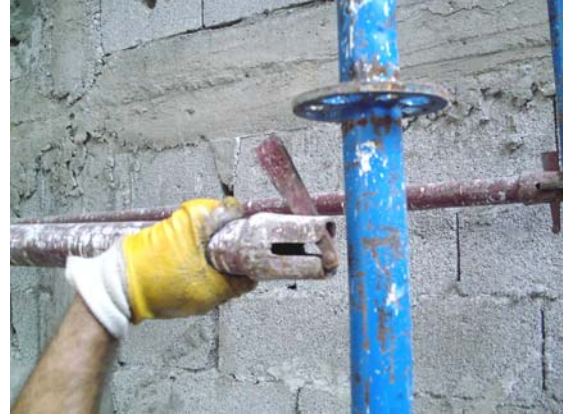
Resim 134: Korkuluğun sökülmüş hali
