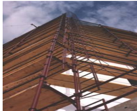
Resim 74: Bina yüksekliği boyunca Platformlar
