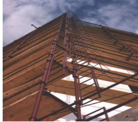
Resim 92: Bina Yüksekliği boyunca iskelenin bitmiş hali
