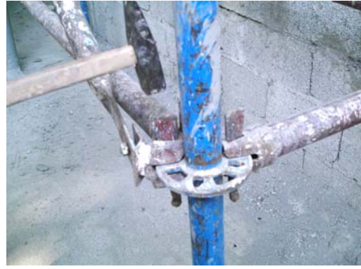
Resim 68: Çapraz bağlantı elemanlarının kama ile montajı
