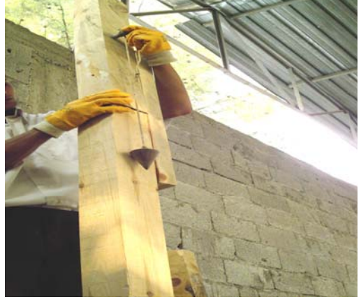
Resim 33: Dikmelere ek yapmak için düşeyliğin çekül ile sağlanması
