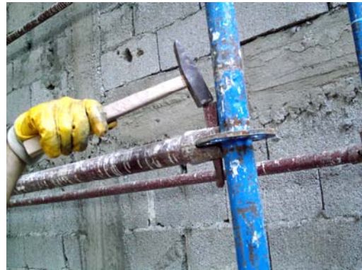
Resim 64: Yatay bağlantı elemanlarının dikmelere kama ile monte edilmesi
