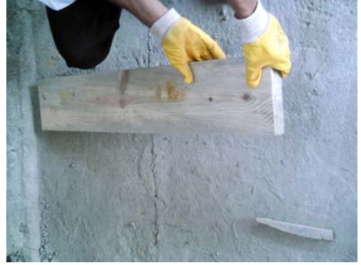
Resim 123: Yastıkların sökülmüş hali
