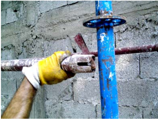
Resim 63: Yatay bağlantı elemanlarının yerine yerleştirilmesi
