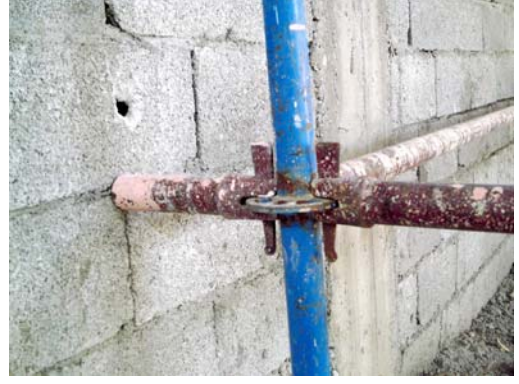
Resim 76: Çelik telin bağlanması için açılan delik
