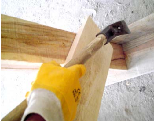
Resim 24: Çaprazların boyunduruklara çakılması Resim 25: Çaprazların çakılmış hali
