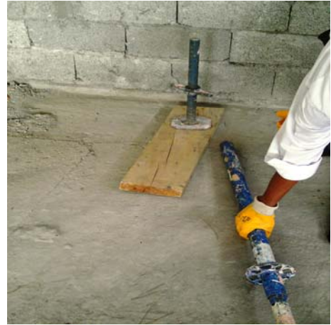
Resim 150: Dikme ayaklarının sökülmüş hali
