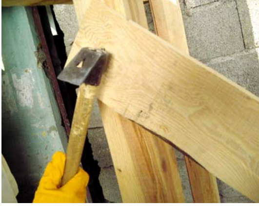
Resim 22: Çaprazların iskele içinden çakılması Resim 23: Çaprazların iskele dışından çakılması
