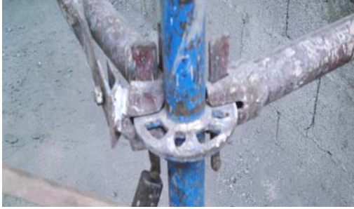
Resim 137: Çaprazların sökülmesi
