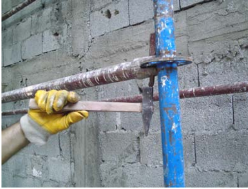
Resim 139: Yatay bağlantıların sökülmesi
