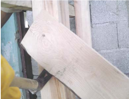
Resim 110: İç çaprazların sökülmesi
