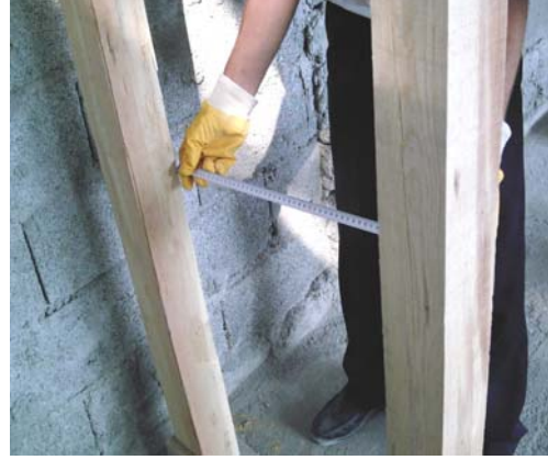
Resim 15: İkinci dikmenin mesafeye uygun yerleştirilmesi
