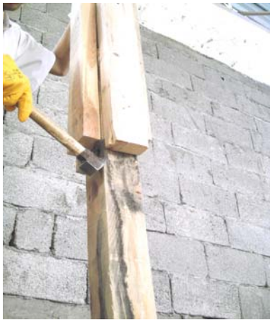
Resim 116: Şaplamaların sökülmesi
