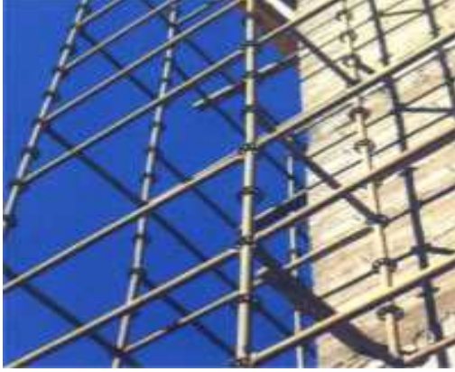
Resim 91: İskele elemanlarının monte edilmiş hali
