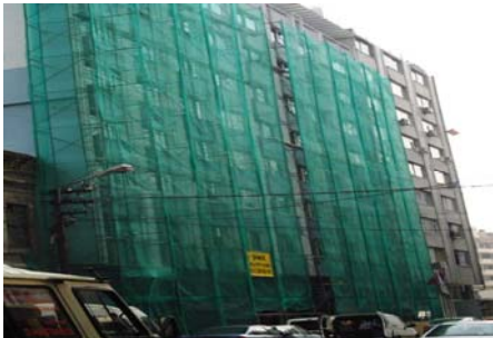
Resim 95.1: İskele dışının kaplanması
