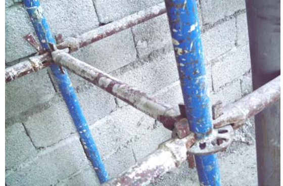
Resim 136: Kalasların sökülmüş hali
