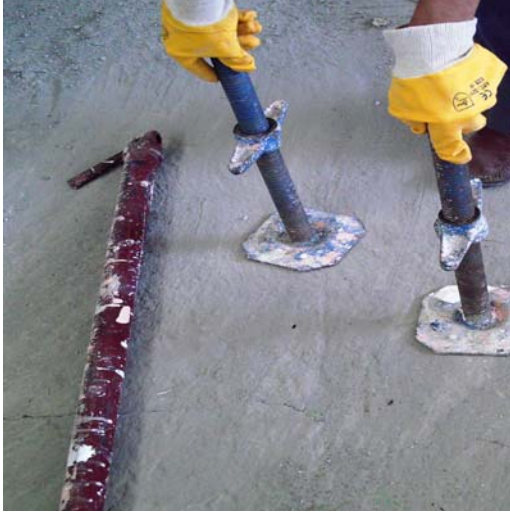
Resim 57: Dikme ayaklarının yerleştirilmesi
