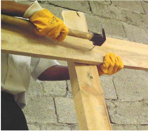
Resim 42: Üst korkuluğun çakılması
