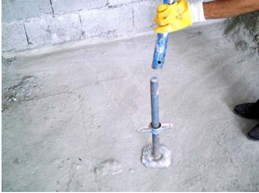
Resim 59: Dikmelerin ayaklara yerleştirilmesi
