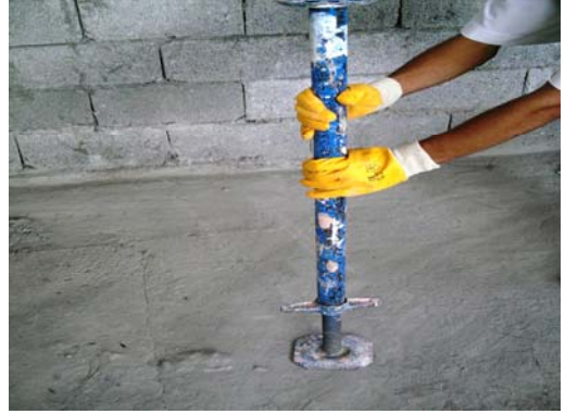
Resim 60: Dikmelerin monte edilmesi
