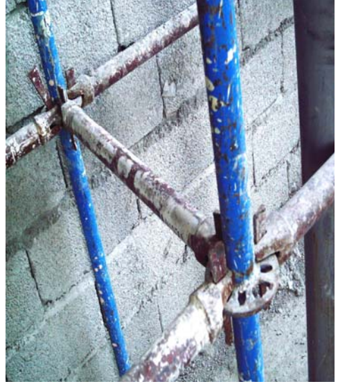
Resim 148: Alt Platform kalasların sökülmüş hali
