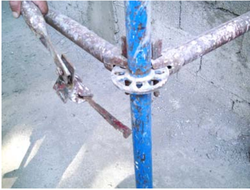
Resim 67: Çapraz bağlantı elemanlarının yerine yerleştirilmesi
