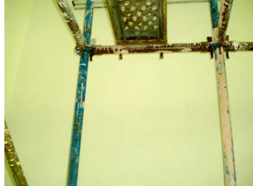
Resim 72: Metal kalasların yerleşmiş hali
