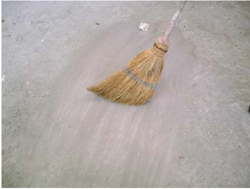
Resim 99: İskele gereçlerinin yerinin temizlenmesi
