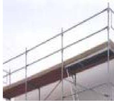
Resim 94: Korkuluk yapılması
