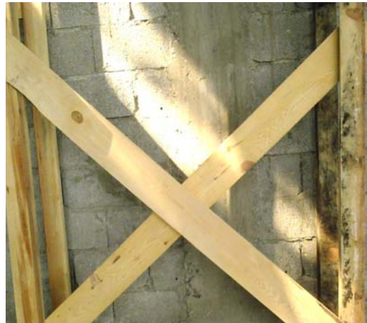
Resim 39: Çapraz kuşaklarla dikmelerin bağlanmış hali
