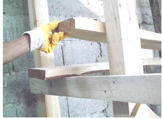
Resim 107: Kalasların Sökülmüş Hali
