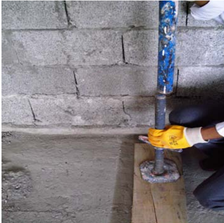
Resim 149: Dikme ayaklarının sökülmesi
