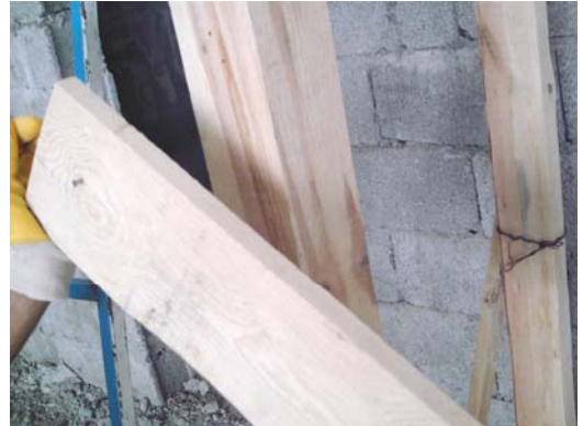
Resim 111: Dış çaprazların sökülmesi
