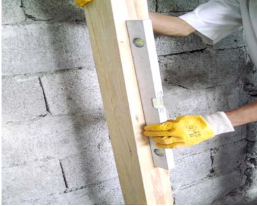
Resim 16: Dikmelerin düşeyliğinin su terazisi ile sağlanması
