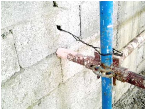
Resim 141: Tel Bağlantıların sökülmesi
