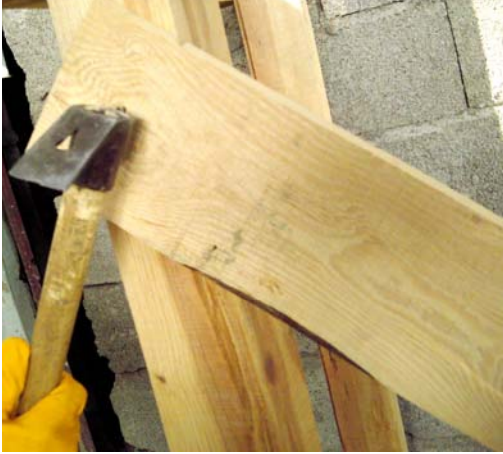
Resim 36: Üst Dikmenin içten çapraz kuşakla bağlanması
