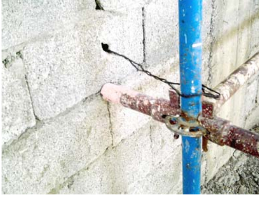
Resim 77: Çelik tel ile iskelenin bina duvarına bağlanması
