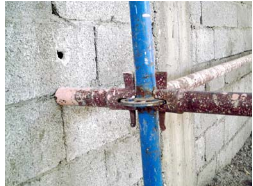
Resim 142: Tel Bağlantıların sökülmüş hali
