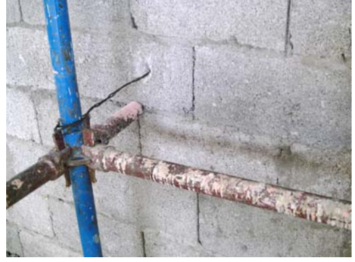
Resim 78: Çelik telin gergin hale getirilmesi
